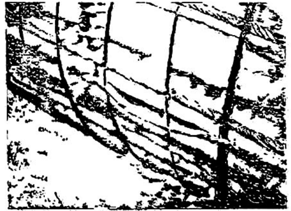
H.03. Giải pháp sai, cài giữ cữ hàn vào cốt thép đai
