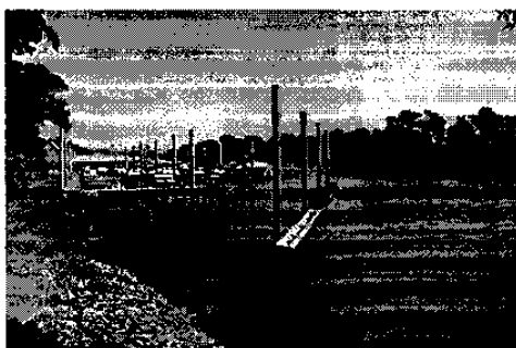
Hình 28 - Dầm chắn chống lại các vật trôi nổi ở thượng lưu
