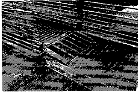
Hình 2 - Bàn nổi giữa cầu dẫn di động với sàn cầu tàu nổi
