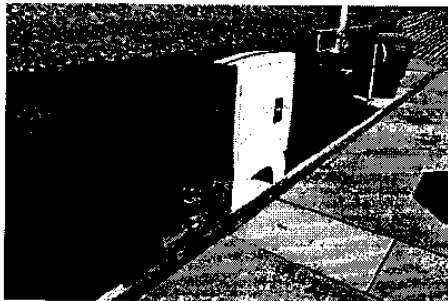
Hình 37 - Hộp cứu hỏa được lắp đặt bên hông cầu tàu
