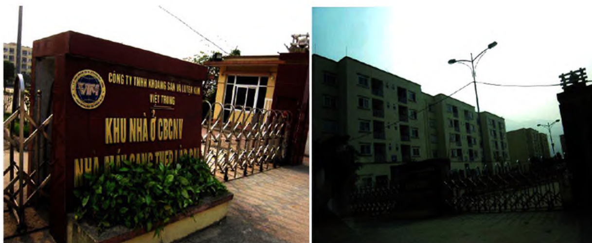
Khu nhà ở cho công nhân tại KCN trên địa bàn huyện Bảo Thắng
