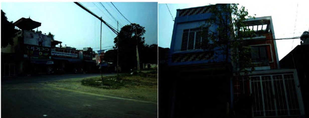
Nhà ở tại khu trung tâm huyện Bảo Thắng
